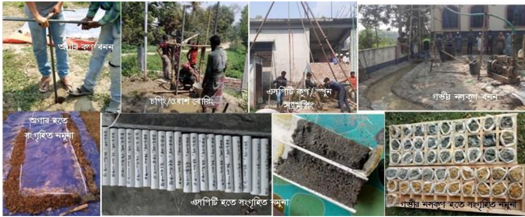
চিত্র-২. আগার কূপ, চপিং/ওয়াশ বোরিং, এসপিটি কূপ/স্পুন স্যাম্পলিং ও গভীর নলকূপ খনন এবং এসব কূপ খননের মাধ্যমে প্রাপ্ত নমুনা
